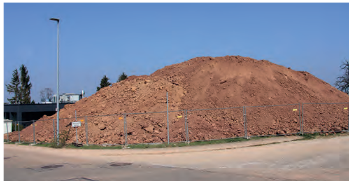
3000 Kubikmeter Erde sollen abtransportiert werden, der Rest soll für den Wiedereinbau auf dem Feuerwehrgelände verwendet werden. Foto: Gemeinde
