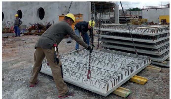
Bis zu einer Tonne schwer sind die Fertigteile für die Decke, die mit dem Kran transportiert werden.
