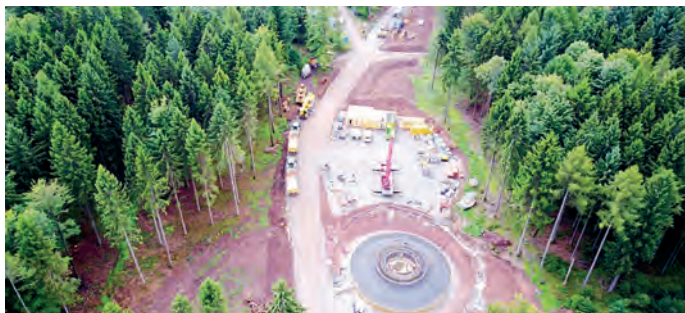
Waldzerstörung Wind-Industrieanlage 10 bei Dennach
