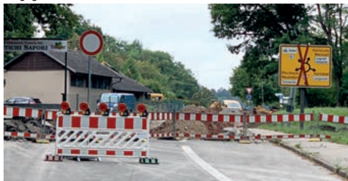
Seit 7. September ist der Kreisel Hasenstock wegen Bauarbeiten gesperrt. Foto: Gemeinde
