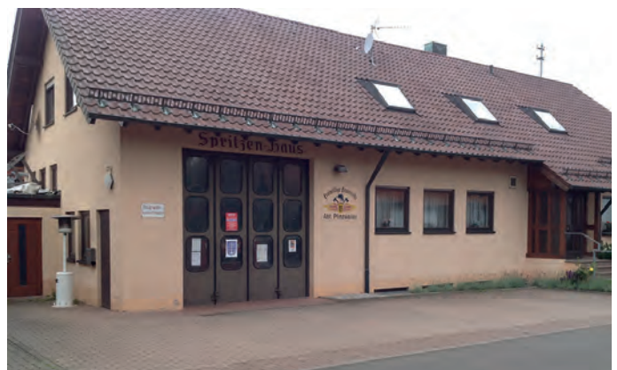
Feuerwehrhaus in Pfinzweiler
