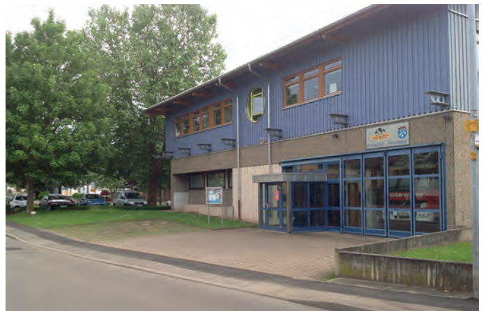
Feuerwehrhaus in Ottenhausen
