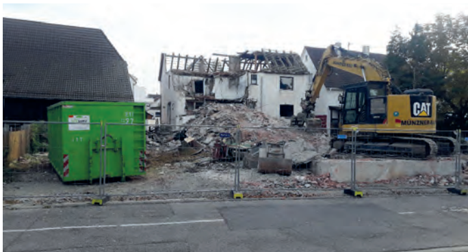
Abbruch ehemals Gaststätte Jägerhof
