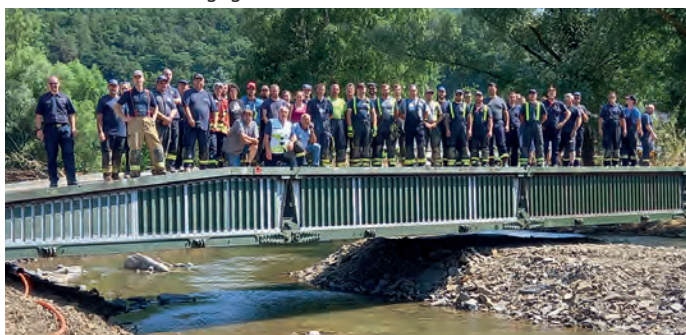
Feuerwehrleute aus dem Enzkreis haben beim Bau einer Behelfsbrücke im Katastrophengebiet in Rheinland-Pfalz mitgeholfen.
