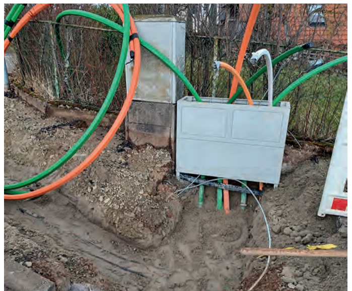
In Ottenhausen wurden bislang 4,6 Kilometer Leitungen verlegt und mehr als 200 Hausanschlüsse erstellt. Foto: Gemeinde Straubenhardt
