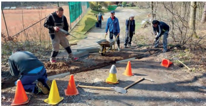
Starke Männer beim Bau der Regenrinne.
