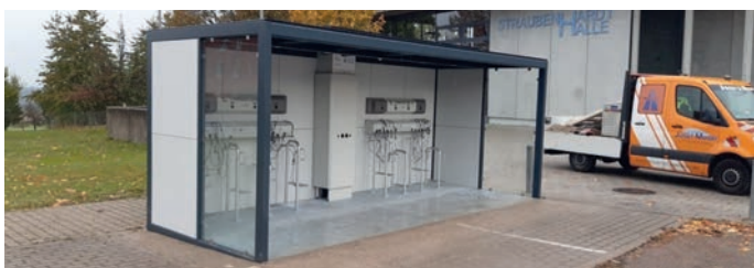
Der sogenannte „Charger Cube“ am Pflugweg bei der Straubenhardthalle, Conweiler.
