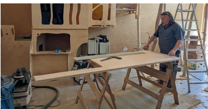
Projektleiter Rainer Ulm beim Vorbereiten des nächsten Holzelements
