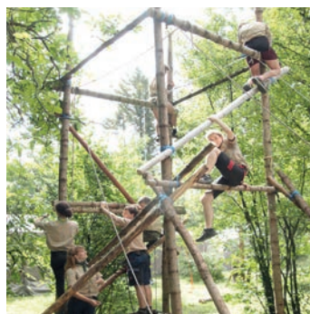
Der Lagerturm entsteht.
