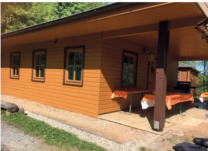
Die Tennishütte erstrahlt in neuem Glanz.
