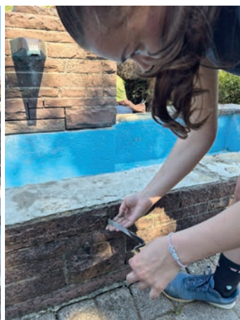
Auch die junge Helferin Kira aus Ottenhausen beteiligte sich engagiert an den Verfugungsarbeiten.
