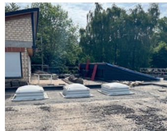
Das Dach während den Sanierungsarbeiten mit den alten Lichtkuppeln.
