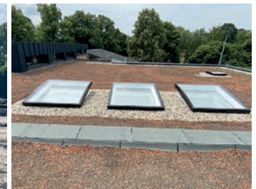
Das neue Flachdach mit den neuen Lichtkuppeln im Hintergrund, links eins der kleinen Pultdächer und rechts die Photovoltaikanlagen.
